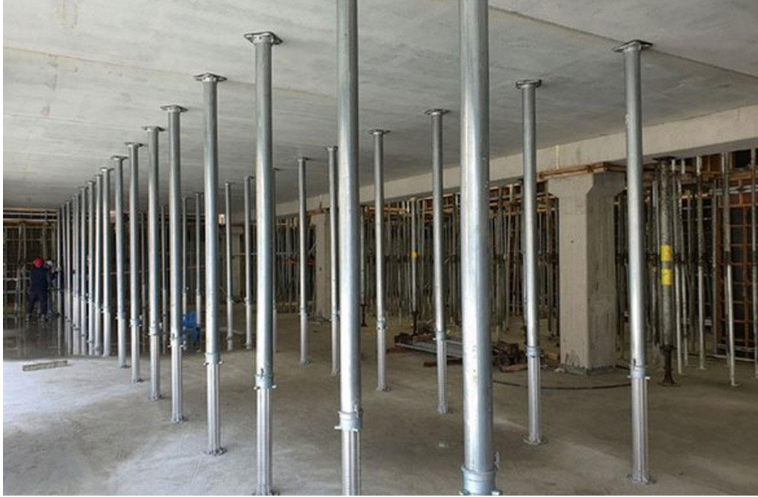
فاصله جک های زیر سقف تیرچه بلوک
