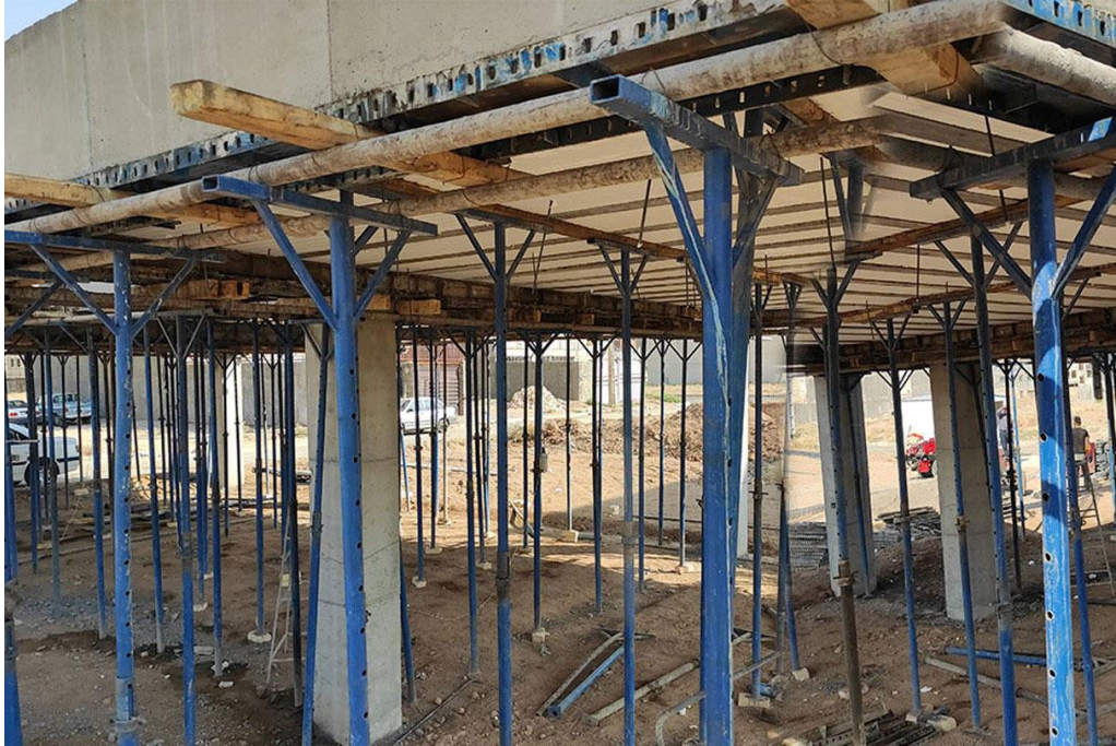
زمان برداشتن جک های زیر سقف
