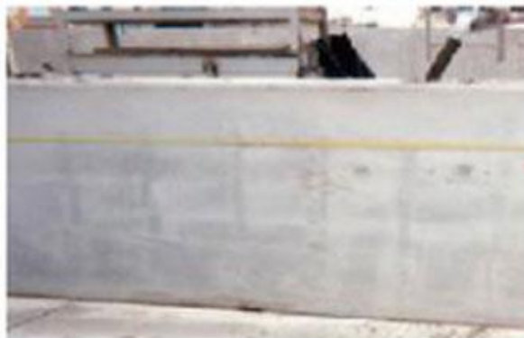
شکل ۲) سطح تمام شده در بتن خود متراکم
