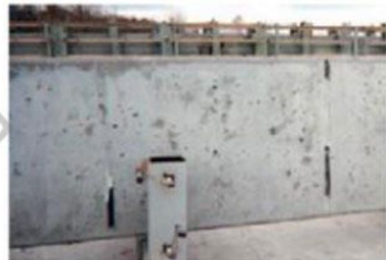
شکل ۱) سطح تمام شده در بتن معمولی
